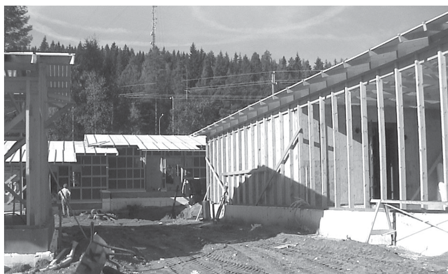
Myllyjärven asumisyksikön rakennusprojekti etenee aikataulun mukaan. Rakennukset ovat jo harjakorkeudessa. Suunnitelman mukaan 24 asuntoa valmistuvat 31.1.2003 mennessä.
