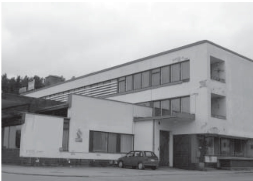
Vanha linja-autoaseman kiinteistö on vuokrattu ruoka-avun käyttöön.
