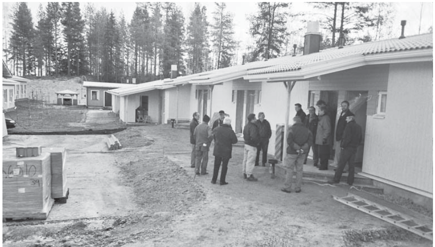
Työmaakokous ennen harjannostajaisia tarkasti työn tuloksia.
