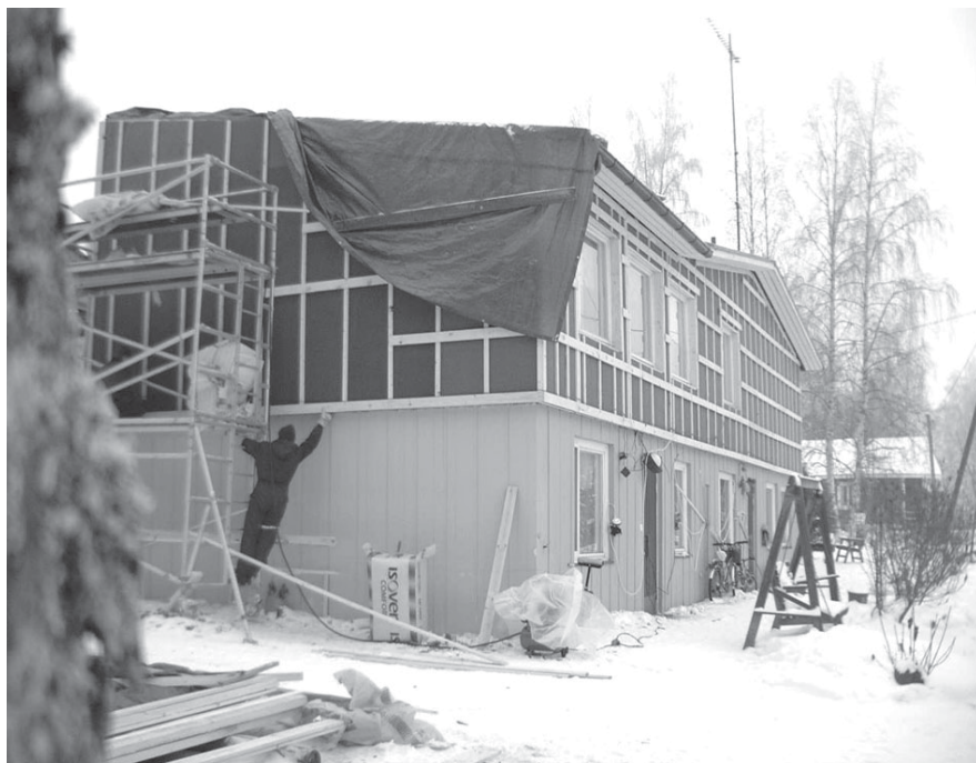
Tekevä-säätiön miehet ovat laittaneet Nurmelaan viiden sentin villat, joka tuntui välittömästi päiväkeskuksen lämmön nousuna.
